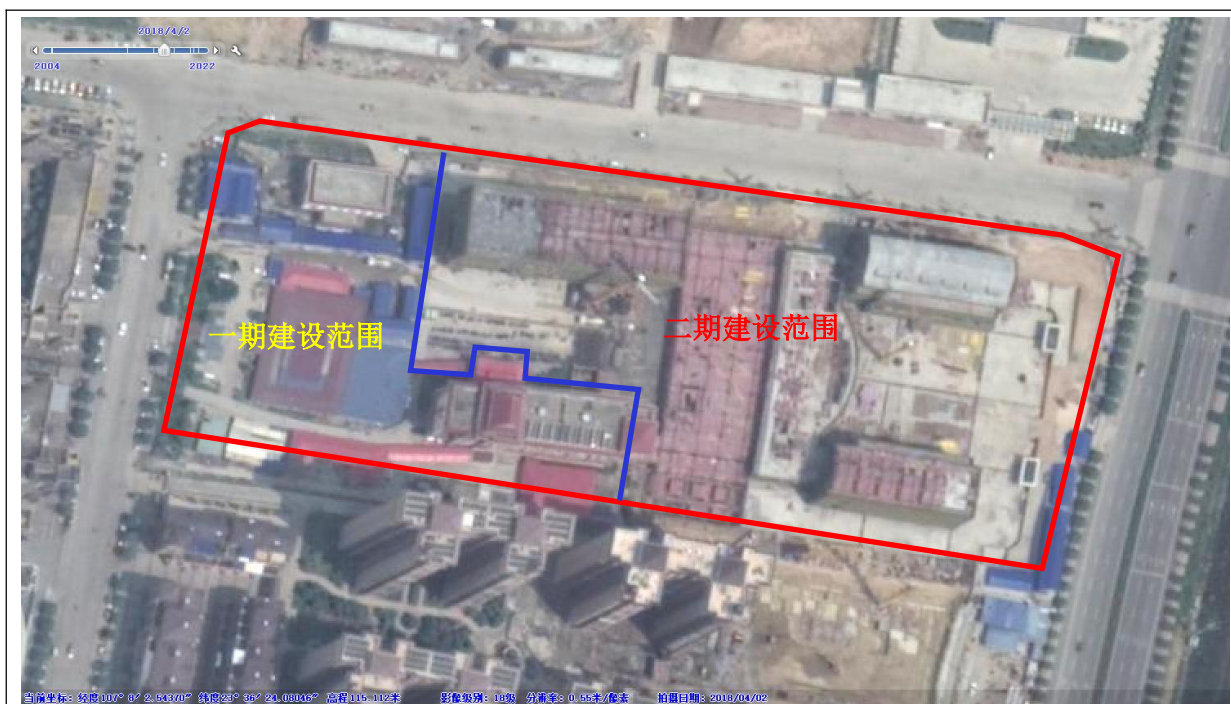
2018 年 4 月项目建设情况图，二期正在建设门诊楼一、门诊/急诊楼
