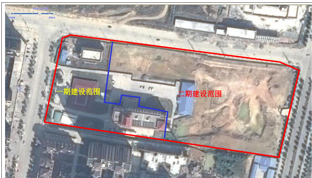
2017 年 1 月项目建设情况图，本项目一期已完成建设，建筑主体已完工，建设区内大部分地面已硬化；二期未开工
