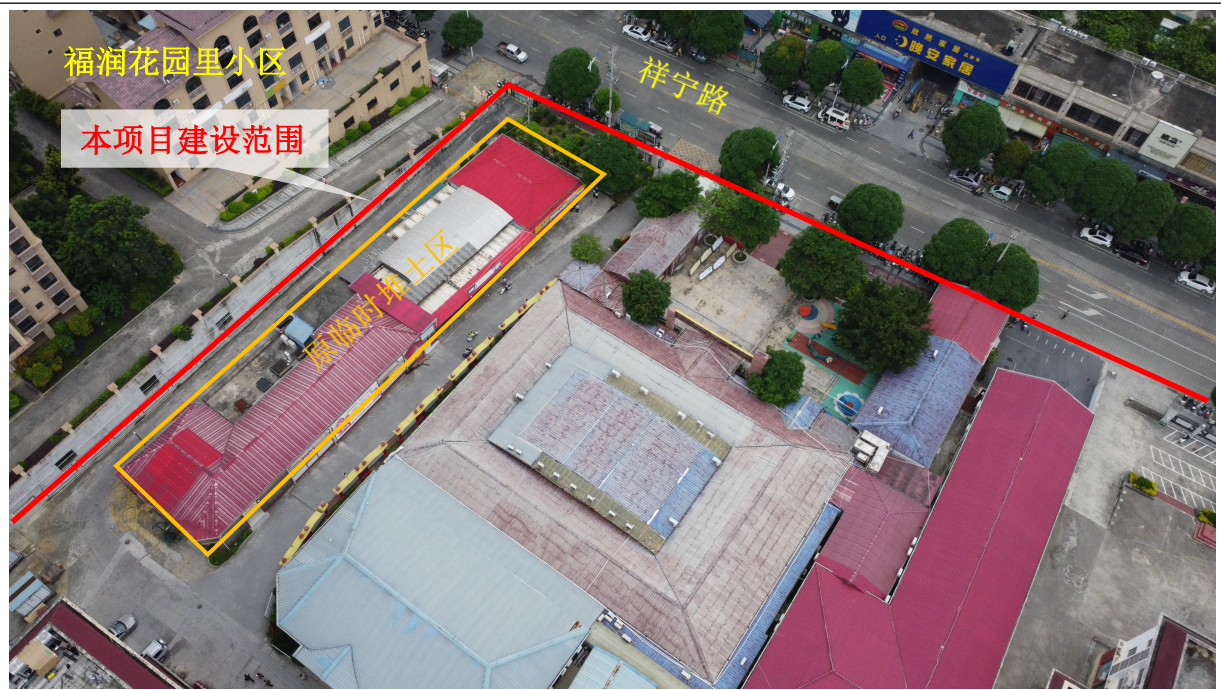
项目临时堆土区场地现状
