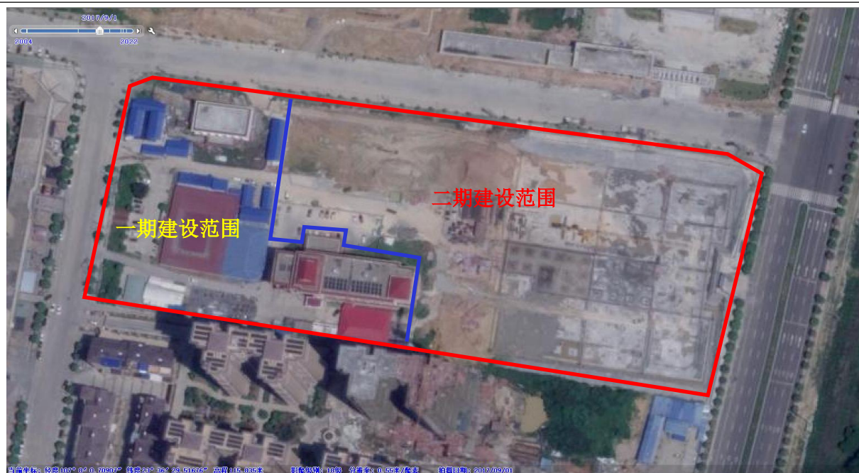
2017 年 9 月项目建设情况图，二期已完成场地平整
