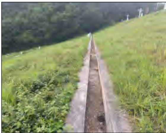
大坝边坡排水沟现状，现状措施运行良好（2023年5月验收现场踏勘拍摄）
