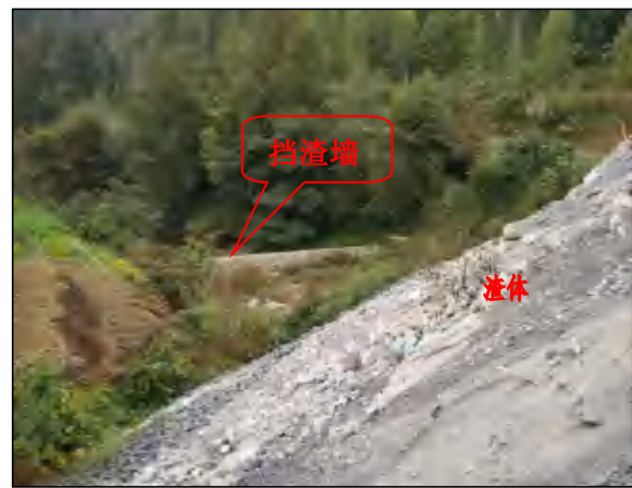
弃渣场堆渣期间挡渣墙布设情况，施工遵循先拦后弃原则（照片由监测单位提供，2017年11月拍摄）
