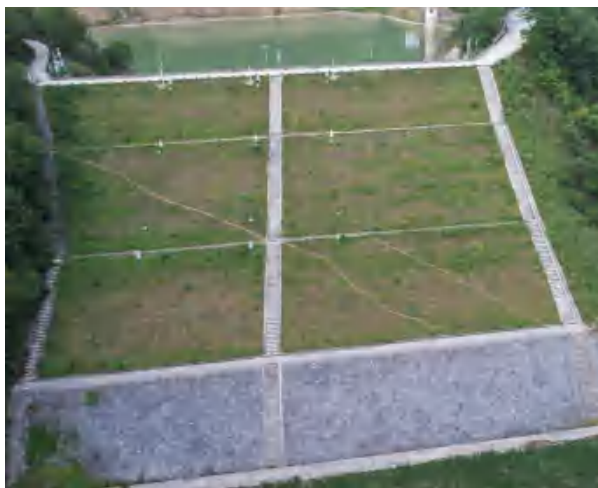
大坝植草护坡现状，现状植被生长状况良好 (2023 年 5 月验收现场踏勘拍摄)
