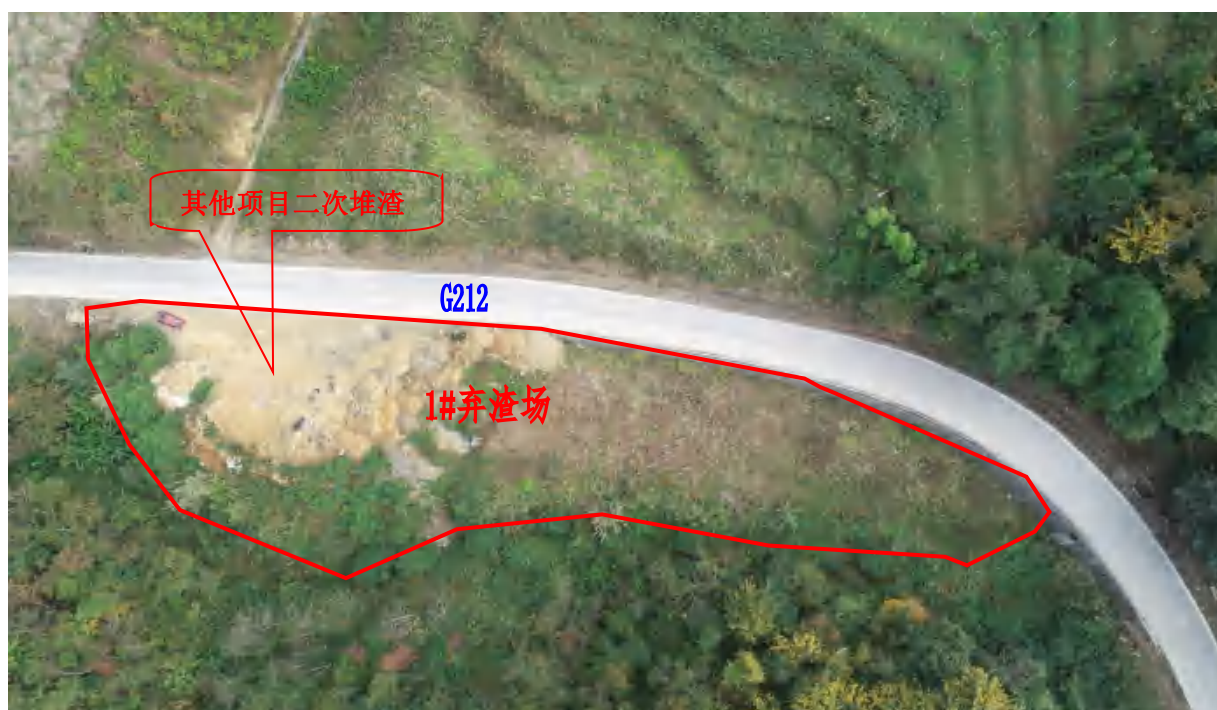
1#弃渣场区用地现状，本项目弃渣结束后已进行绿化恢复，但现状部分用地被其他项目用于堆渣，地表裸露，渣场现状总体较为稳定（2023年12月）
