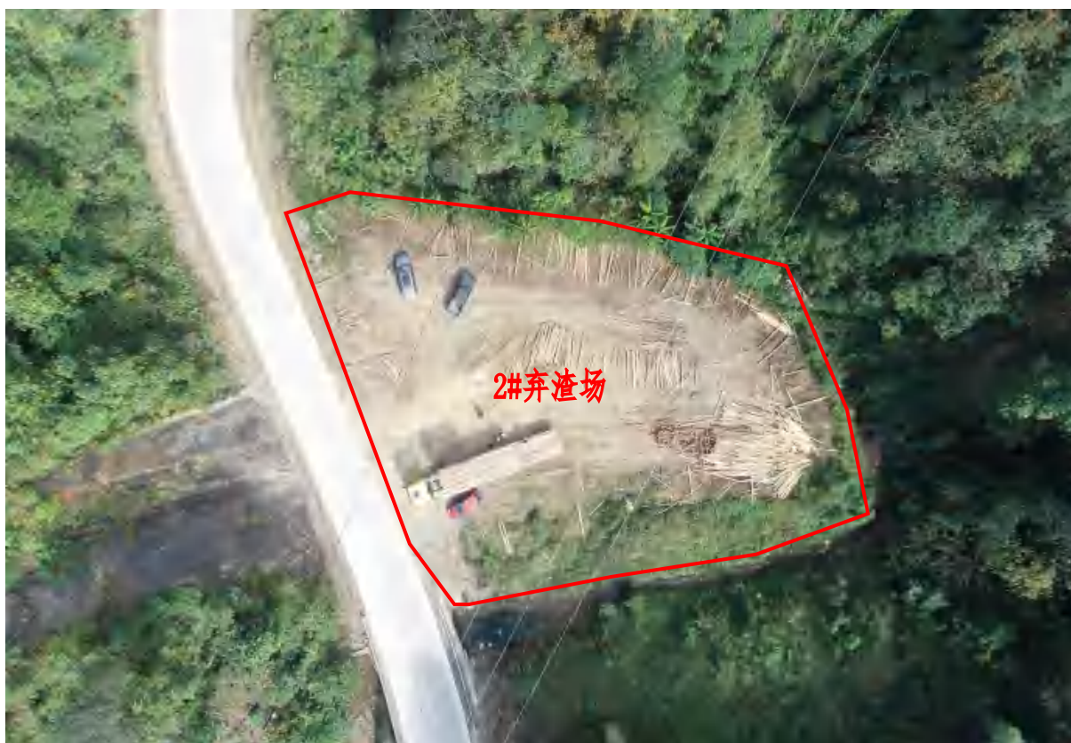
2#弃渣场区用地现状，本项目弃渣结束后已进行绿化恢复，但现状用地用于木材堆放周转，地表裸露，渣场现状总体较为稳定（2023 年 12 月）
