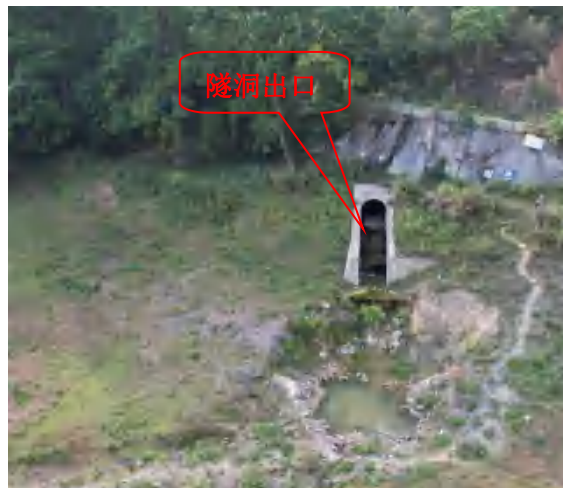
输水隧洞出口周边植草护坡现状，现状植被生长状况良好 (2023 年 5 月验收现场踏勘拍摄)
