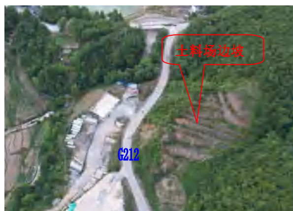
土料场边坡植被生长现状，植被养护一般，边坡坡面植被覆盖度较低（2023 年 5 月）
