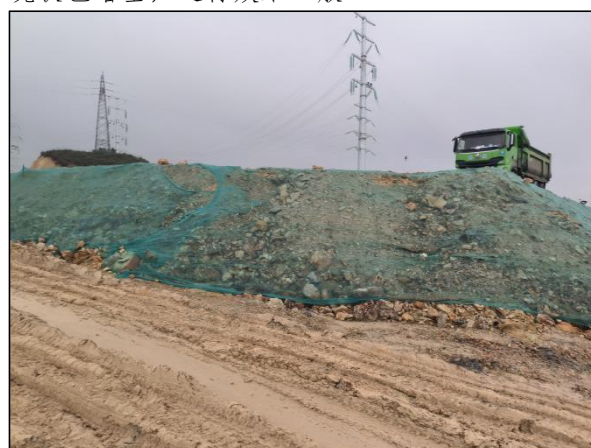
2#临时堆土场堆土临时苫盖现状图，措施措施现状运行效果良好
