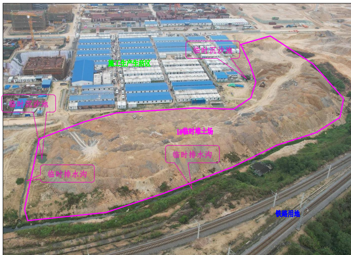
1#临时堆土场用地现状图，堆土边界的临时排水沟、临时沉沙池现状运行效果较好，因堆土场土方随进随出变化较快，土体表面施工未采取临时苫盖
