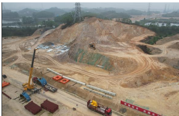
预留发展用地东南面现状图，未扰动区域因高压线塔未迁移，施工未建设，对于形成的临时边坡，施工已合理削坡，边坡较为稳定，未造成水土流失危害
