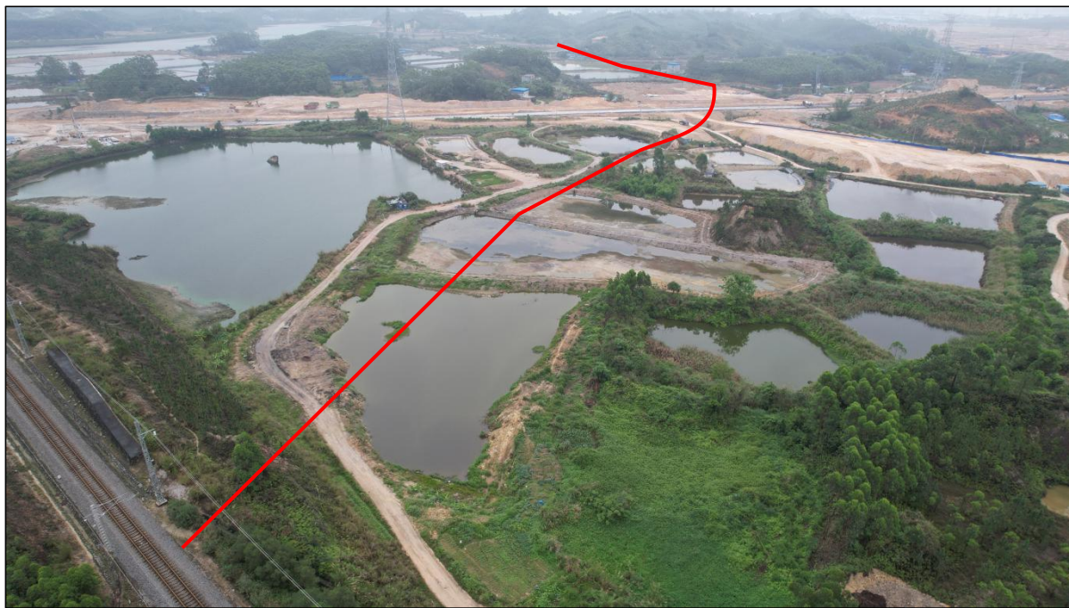
厂外管带区北段用地现状图，现状未施工建设，用地呈现坑塘水面、其他草地等地貌，无较大水土流失
