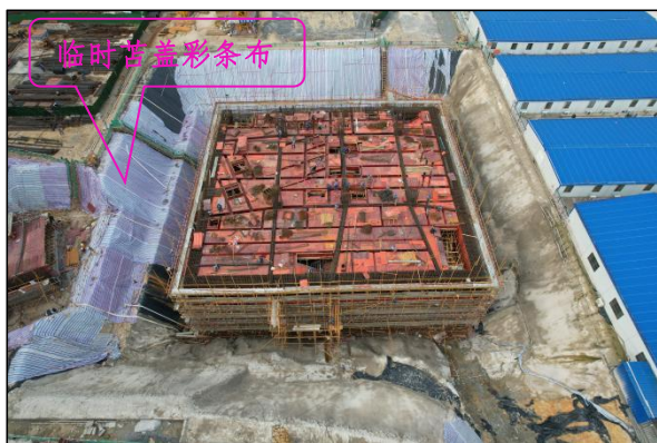
厂区建设区中部，构筑物基础建设形成的临时基坑边坡，施工已进行边坡修整并苫盖彩条布，边坡较为稳定
