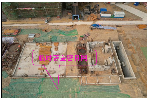
厂区建设区裸露地面、基坑边坡临时苫盖现状图，措施现状运行效果良好
