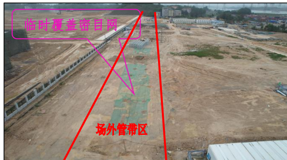
场外管带区中段已施工区域用地现状图，该区原地貌为已平整的裸土地，施工裸露地表施工已采取临时覆盖密目网，现状无较大水土流失
