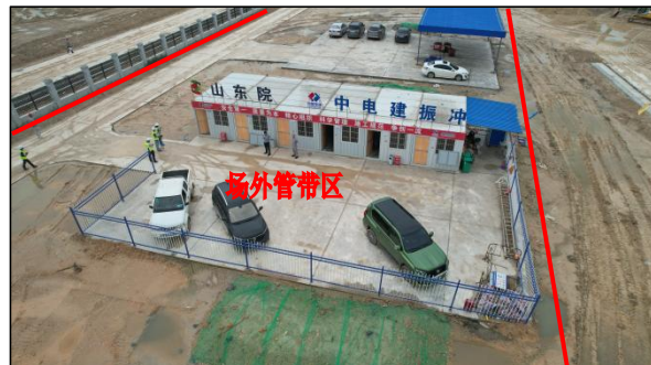
场外管带区中段已施工区域用地现状图，该区原地貌为已平整的裸土地，后期拟建转运站，现状施工用于临时办公点建设，现场无较大水土流失
