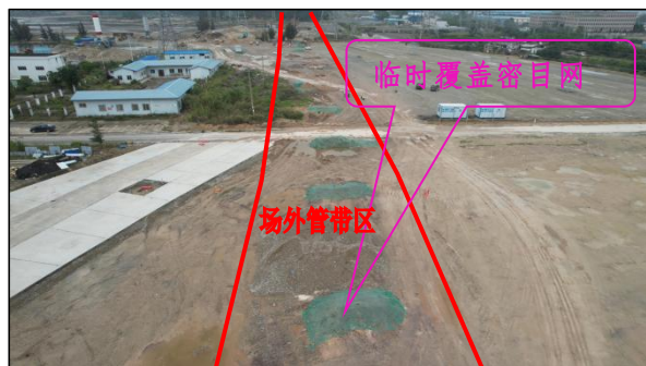
场外管带区南段已施工区域用地现状图，该区原地貌为已平整的裸土地，本项目基础建设开挖临时堆放的土方，施工已采取临时覆盖密目网，现状无较大水土流失
