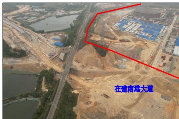
预留发展用地东南面现状图，未扰动区域因高压线塔未迁移，施工未建设，对于形成的临时边坡，施工已合理削坡，边坡较为稳定，未造成水土流失危害
