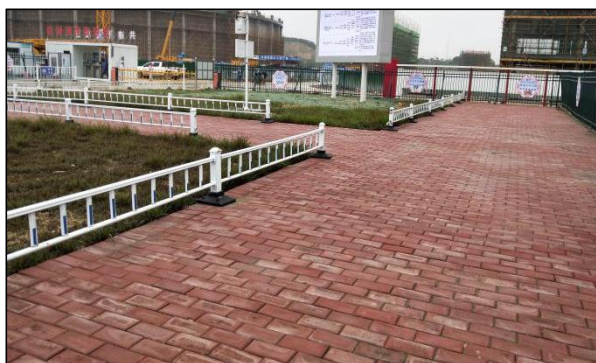
施工生产生活区临时透水砖铺装现状图，措施现状运行效果良好
