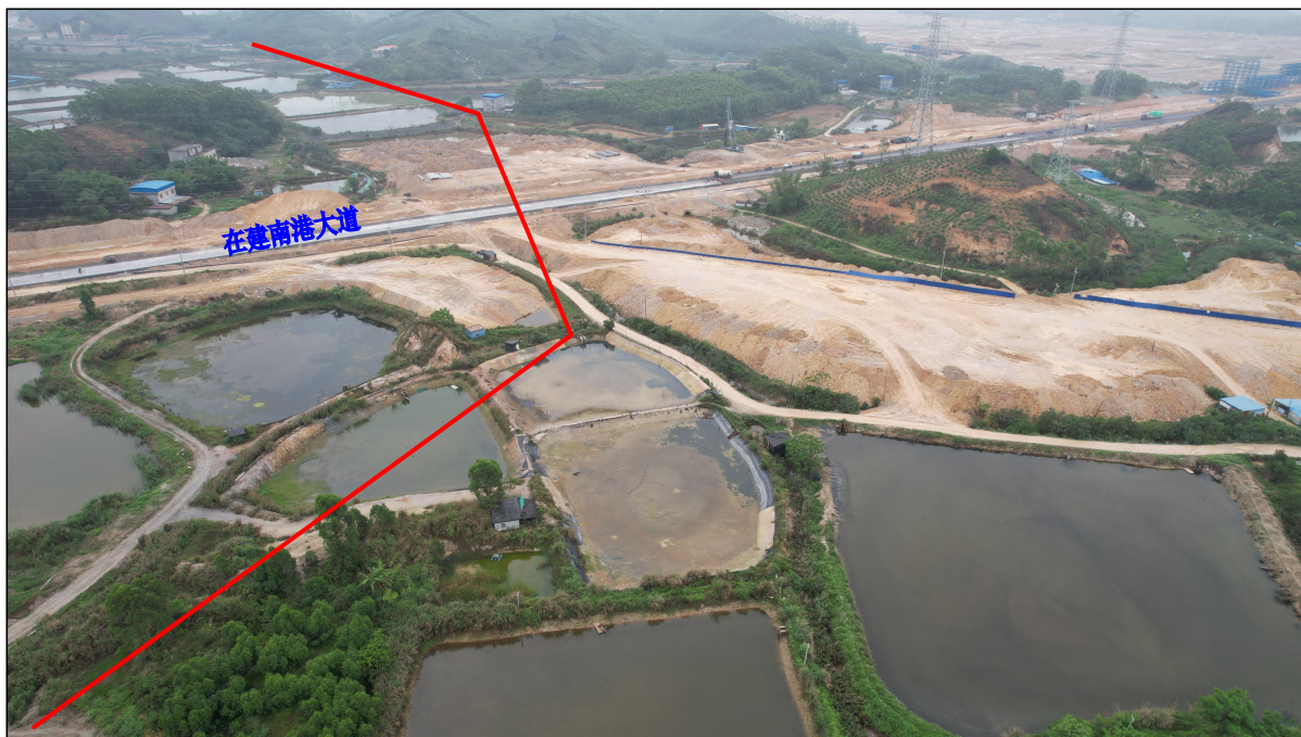
厂外管带区北段跨南港大道铺设用地现状图，现状本项目未施工建设，南港大道处于建设阶段，本项目用地呈现坑塘水面、坑塘水面等地貌，现状用地产生的水土流失主要为南港大道施工造成
