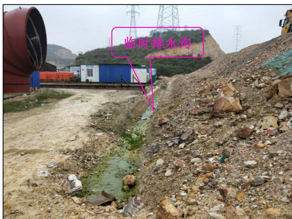
2#临时堆土场临时排水沟现状图，措施现状运行效果良好
