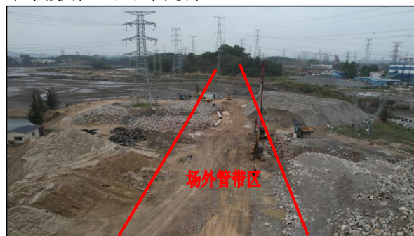
场外管带区南段已施工区域用地现状图，该区原地貌为已平整的裸土地，本项目基础建设开挖临时堆放的土方，施工已采取临时覆盖密目网，现状无较大水土流失
