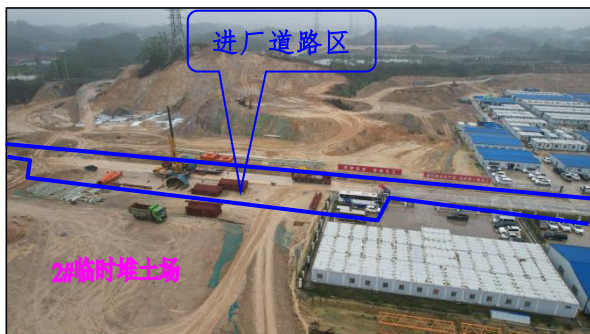
进厂道路区现状图，现状用于施工临时通道，用地交界处水土流失主要为南港大道路基建设造成，交界处的水土流失防治责任本季度纳入南港大道
