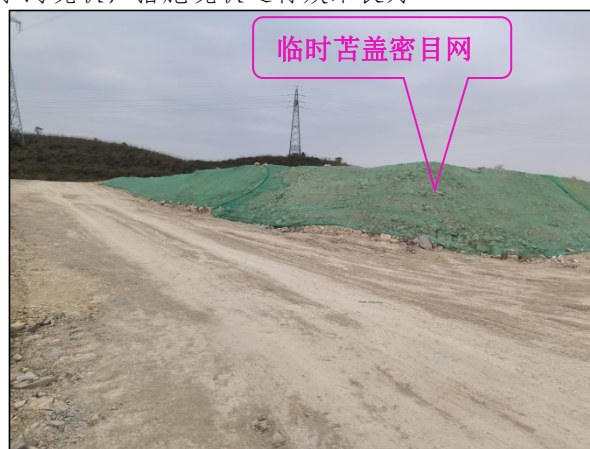
2#临时堆土场堆土边坡坡面临时苫盖现状图，措施现状运行效果良好
