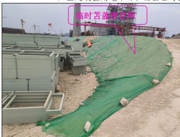
2#临时堆土场堆土边坡坡面临时苫盖现状图，措施现状运行效果良好
