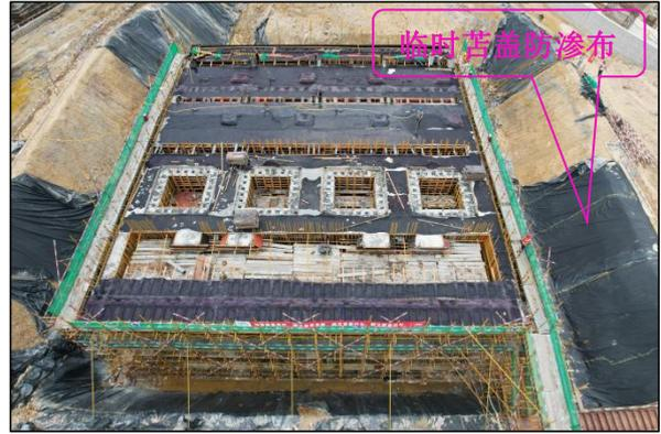
厂区建设区南面及中部施工裸露地面、构筑物基坑现状图，措施现状运行效果良好
