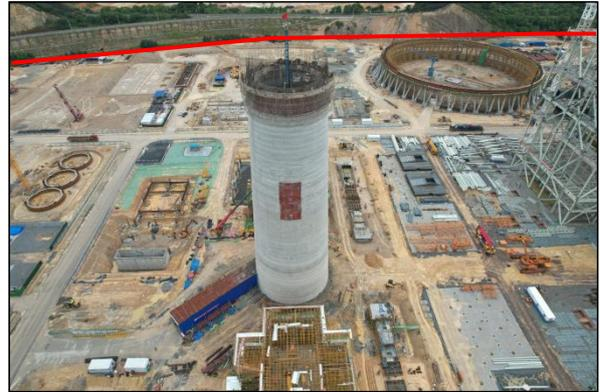
厂区建设区西面、中部建设现状图，主体正在进行构筑物基础建设，场地临时排水采用临时排水沟排水形式，但施工未设置临时沉沙池，部分泥沙随雨水直接汇入临时排水沟，造成一定水土流失，但现场无泥沙淤积堵塞排水沟的现象，未造成水土流失危害
