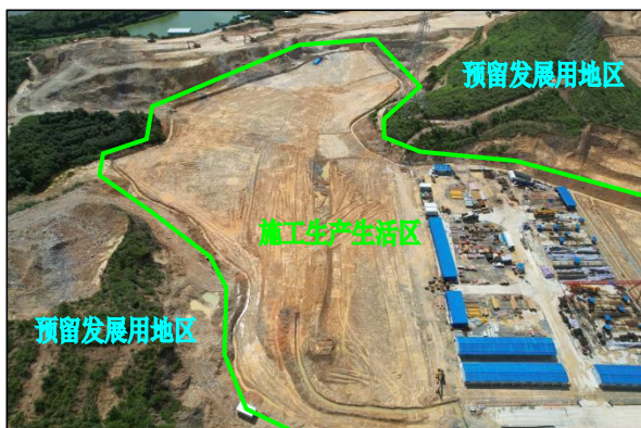
施工生产生活区北面现状图，现状进行基础建设，施工在用地边界处布设临时排水沟，排水效果良好
