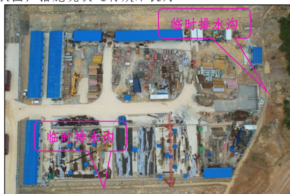
施工生产生活区东面临时排水沟现状图，措施现状运行效果良好
