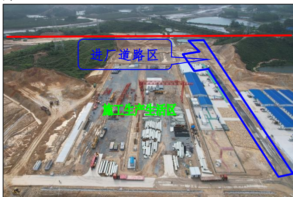
进厂道路区、施工生产生活区中部施工现状图，本季度进厂道路区用于施工生产生活区施工道路建设
