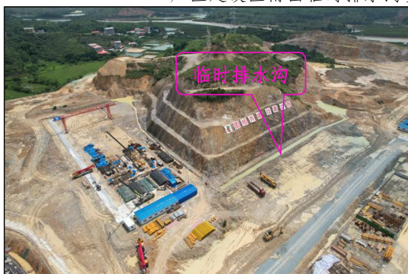
厂区建设区用地北面临时排水沟现状图，措施现状运行效果良好
