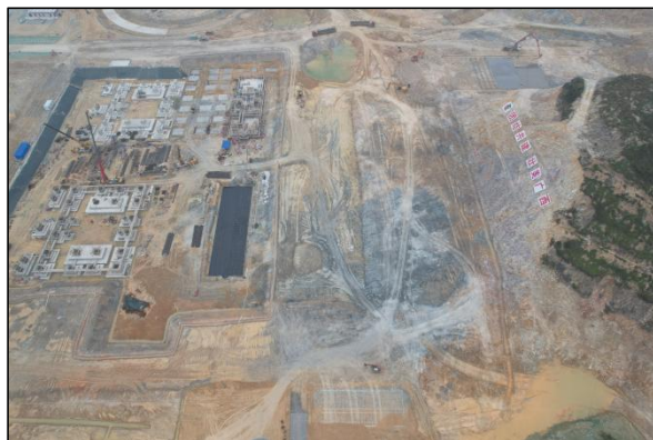
厂区建设区西面、中部建设现状图，主体正在进行构筑物基础建设，场地临时排水采用临时排水沟排水形式，但施工未设置临时沉沙池，部分泥沙随雨水直接汇入临时排水沟，造成一定水土流失，但现场无泥沙淤积堵塞排水沟的现象，未造成水土流失危害
