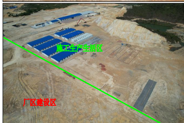
施工生产生活区布置现状图，本季度施工生产生活区开始建设，均布设在预留发展用地区内，施工正在进行基础建设，同时在地中部及边界处合理布设临时排水沟，但未布设临时沉沙池
