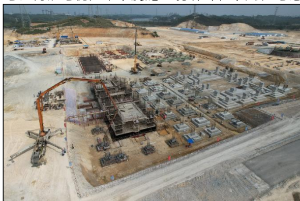
厂区建设区中部建设现状图，主体正在进行构筑物基础建设
