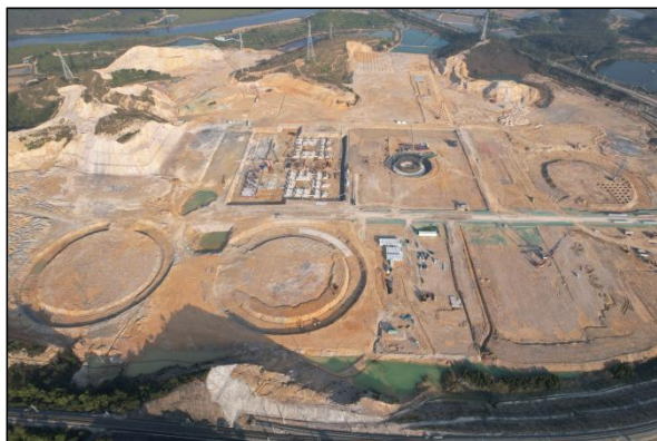
厂区建设区西面、中部建设现状图，主体正在进行构筑物基础建设，场地临时排水采用临时排水沟排水形式，但施工未设置临时沉沙池，部分泥沙随雨水直接汇入临时排水沟，造成一定水土流失，但现场无泥沙淤积堵塞排水沟的现象，未造成水土流失危害
