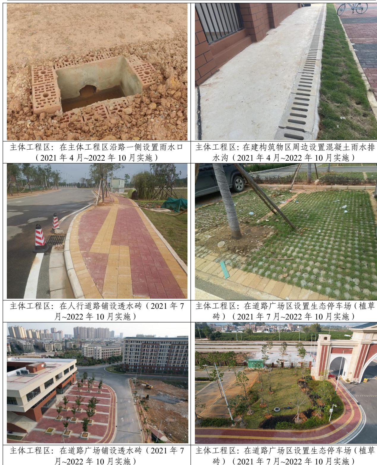
图 3.5-1 水土保持工程措施实施建设图
