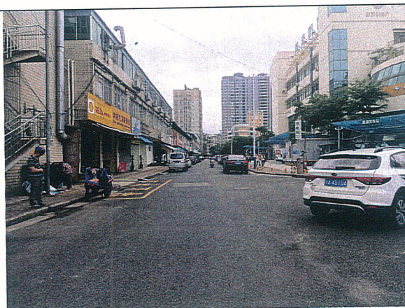
道路硬化现状 (二)
