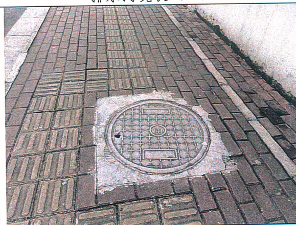
雨水检查井现状 (二)
