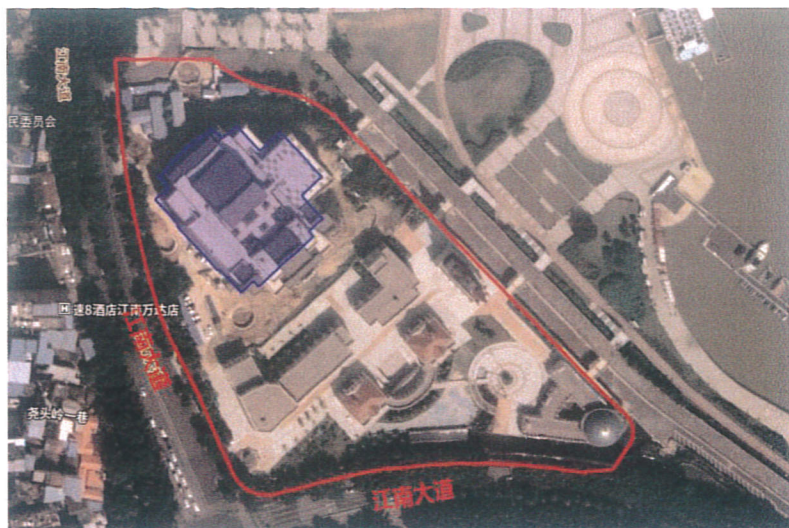
2021 年 10 月项目建设情况图，本项目建设区工程已基本完成，建筑主体已完工，项目区内大部分地面已硬化，水土流失量较小
