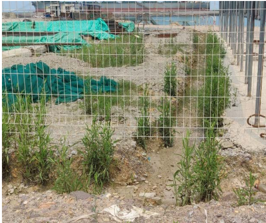
2022 年 6 月~2022 年 7 月，施工生产区临时排水沟建设，临时排水沟宽 50cm，深 30cm
