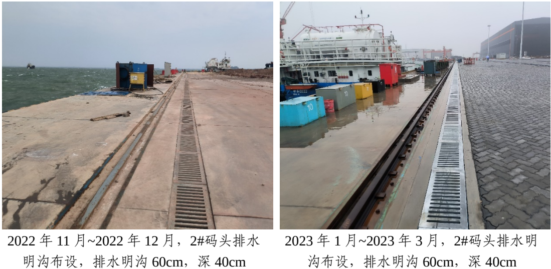
图 3.5-1 工程措施实施建设图
