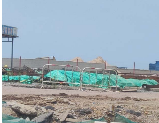
2021 年 3 月~2022 年 6 月，施工生产区的施工材料采用密目网进行临时覆盖。
