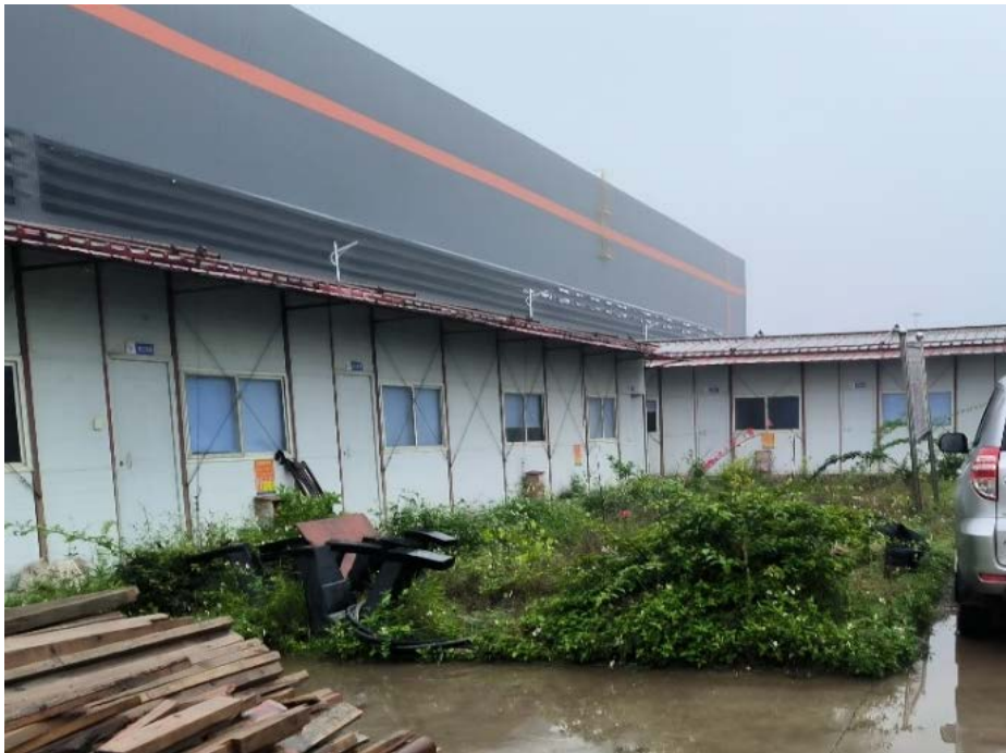
2021 年 3 月，施工生活区撒播草籽，撒播面积 0.02hm 2
