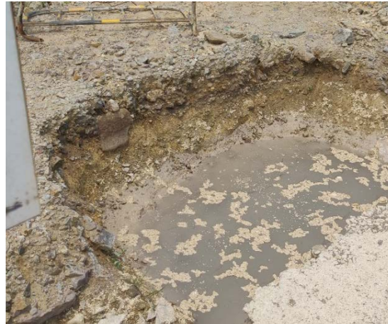
2021 年 12 月，施工生产区临时沉沙池建设，临时沉沙池长 1.5m，宽 1.5m，深 1.0m
