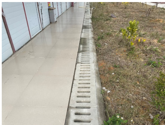
2021 年 7 月，施工生活区临时排水沟建设，排水沟宽 40cm，深 40cm，采用浆砌砖结构
