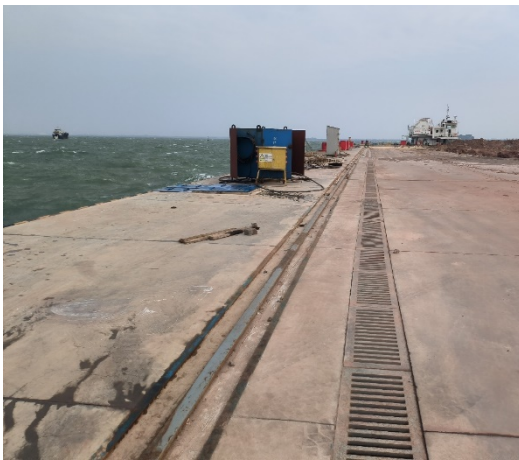
2022 年 11 月~2022 年 12 月，2#码头排水明沟布设，排水明沟 60cm，深 40cm
