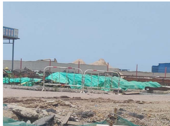
2021 年 3 月~2022 年 6 月，施工生产区的施工材料采用密目网进行临时覆盖。
