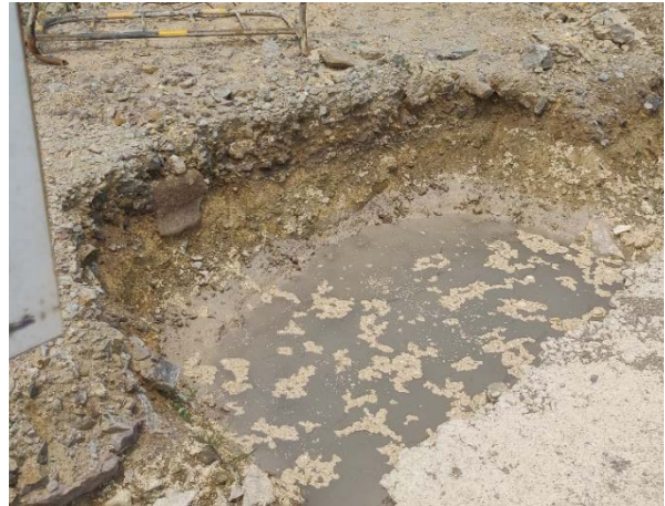
2021 年 12 月，施工生产区临时沉沙池建设，临时沉沙池长 1.5m，宽 1.5m，深 1.0m
