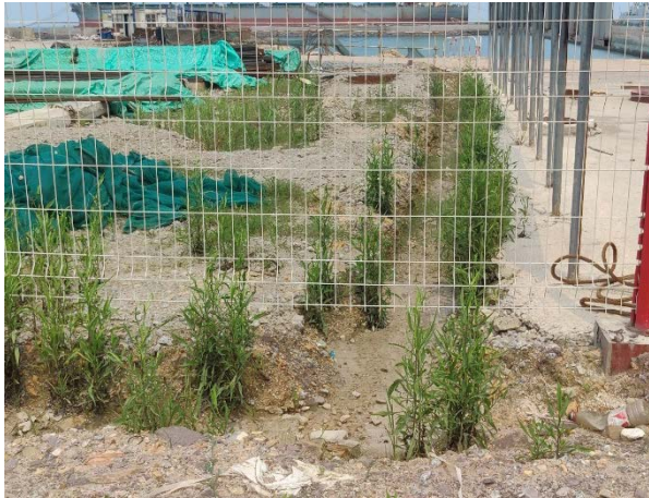
2022 年 6 月~2022 年 7 月，施工生产区临时排水沟建设，临时排水沟宽 50cm，深 30cm
