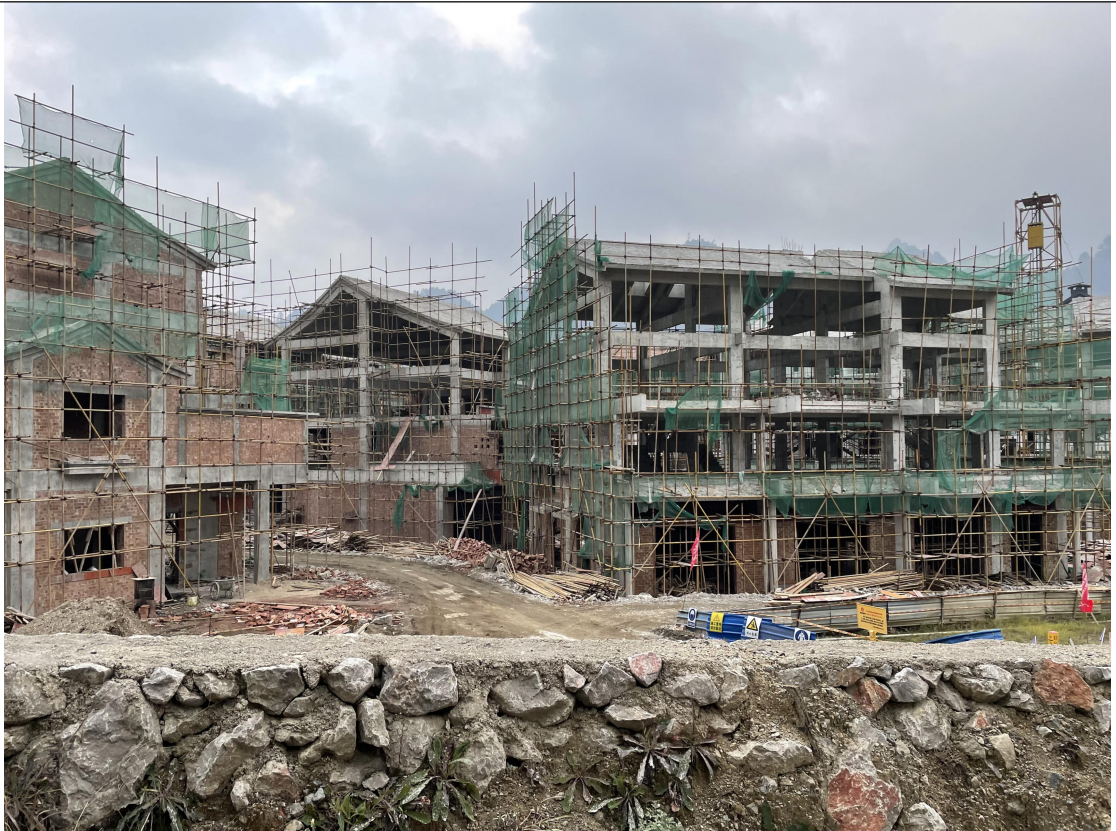
主体工程区施工现状（三）
