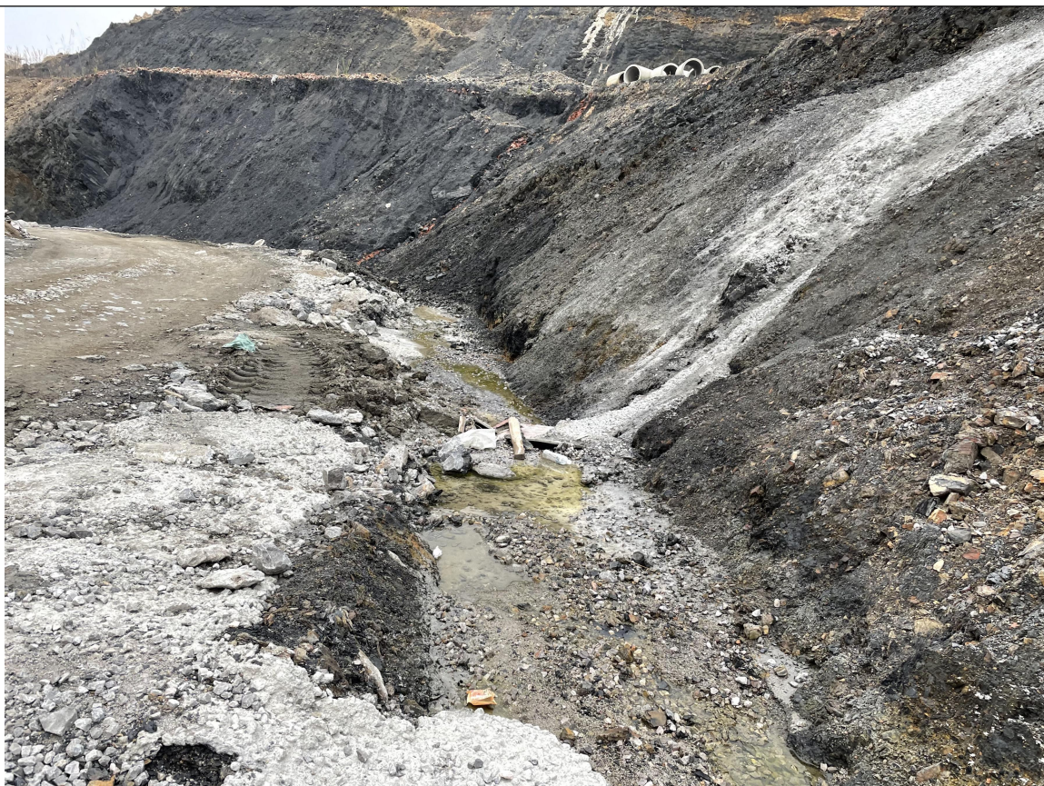
边坡区施工现状（一）
