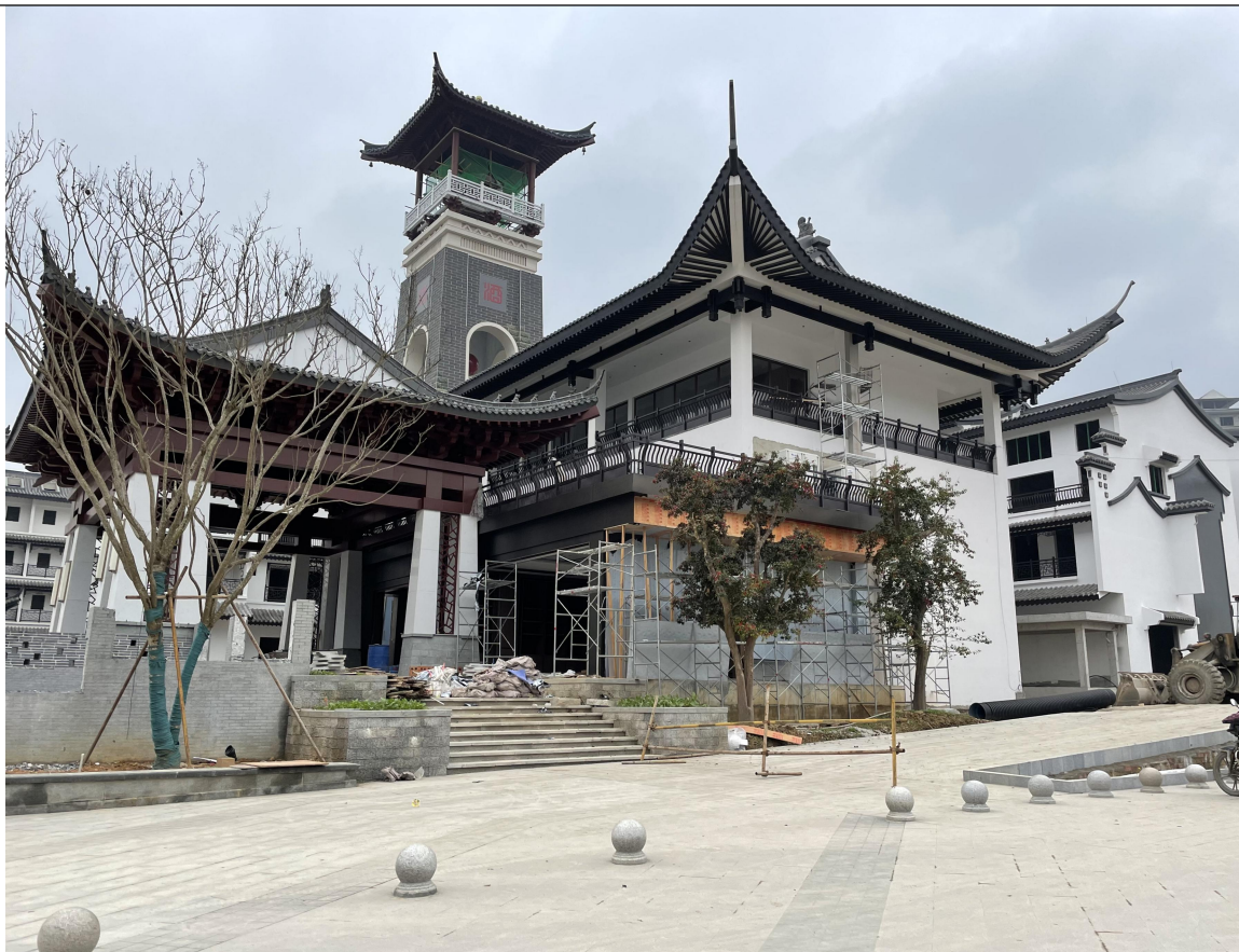
主体工程区施工现状（六）
