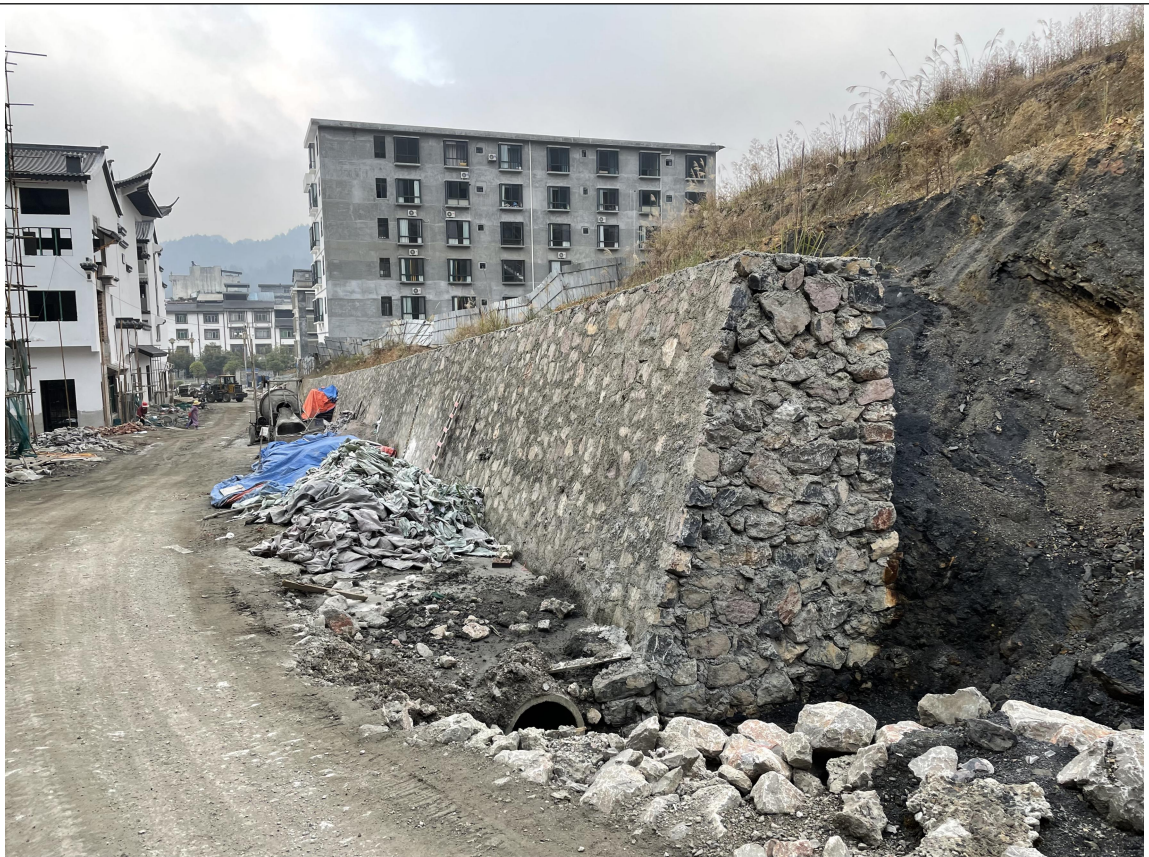
边坡区施工现状（二）
