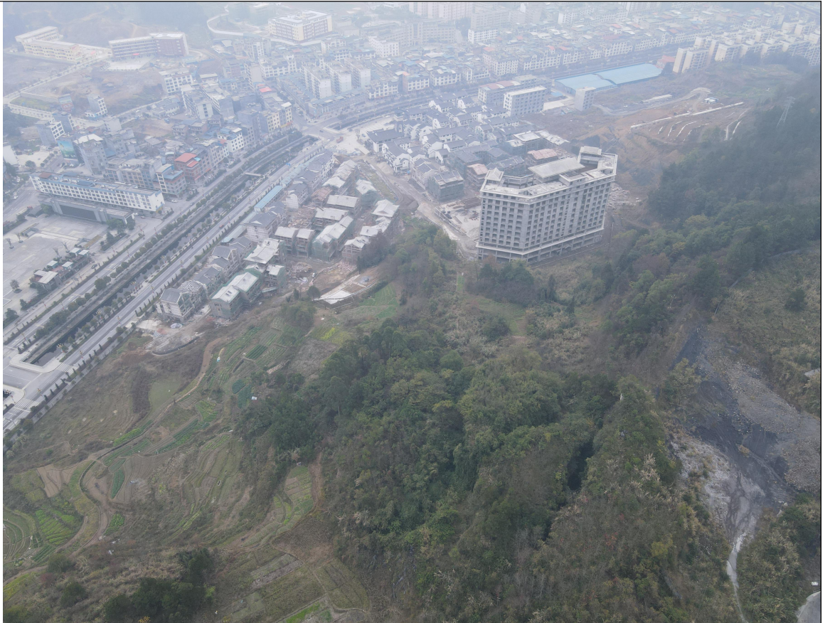
主体工程区施工现状（一）
