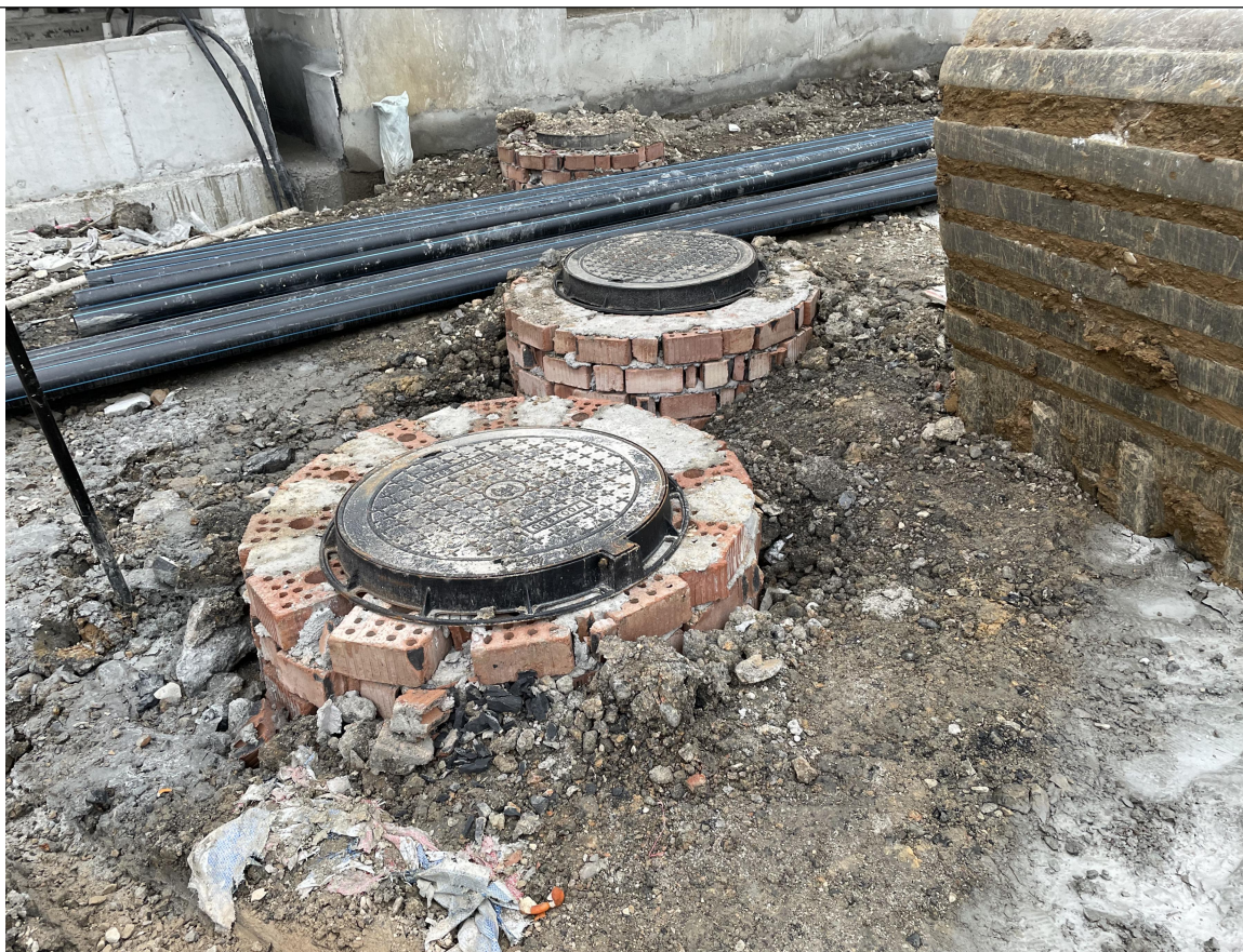
主体工程区施工现状（五）
