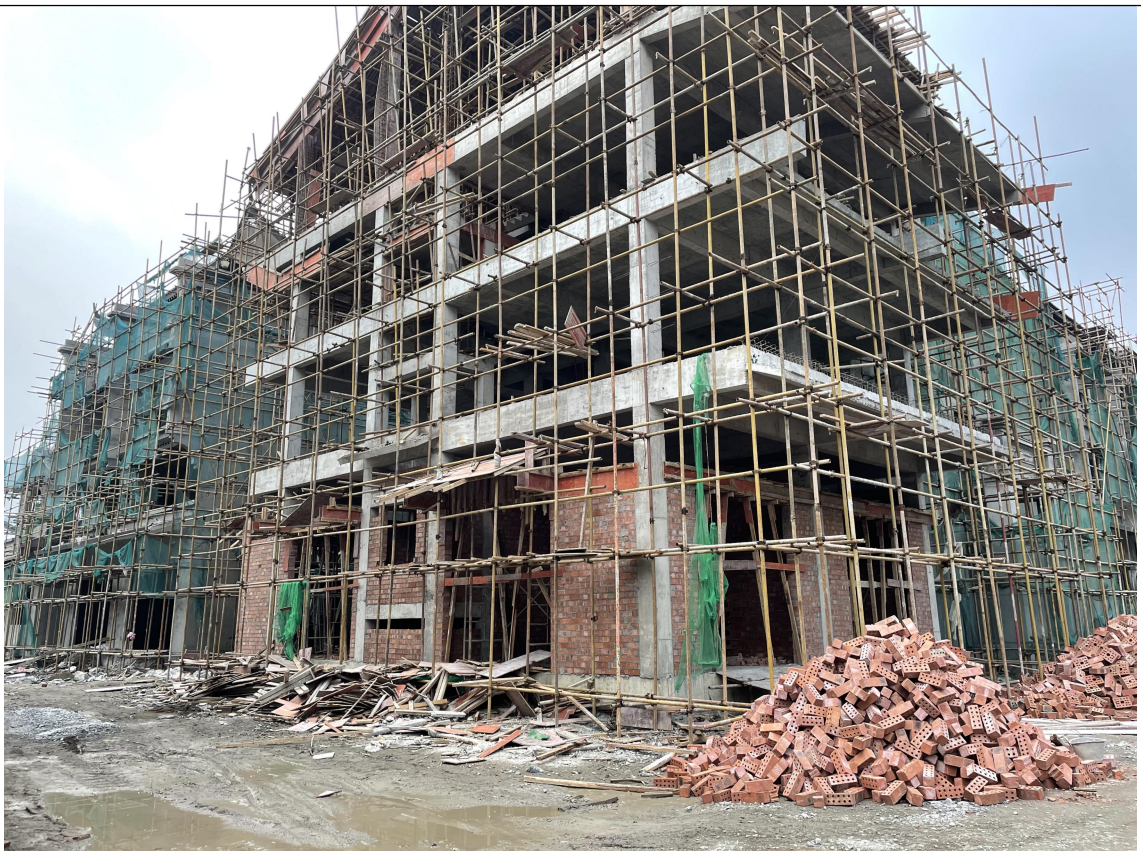
主体工程区施工现状（四）
