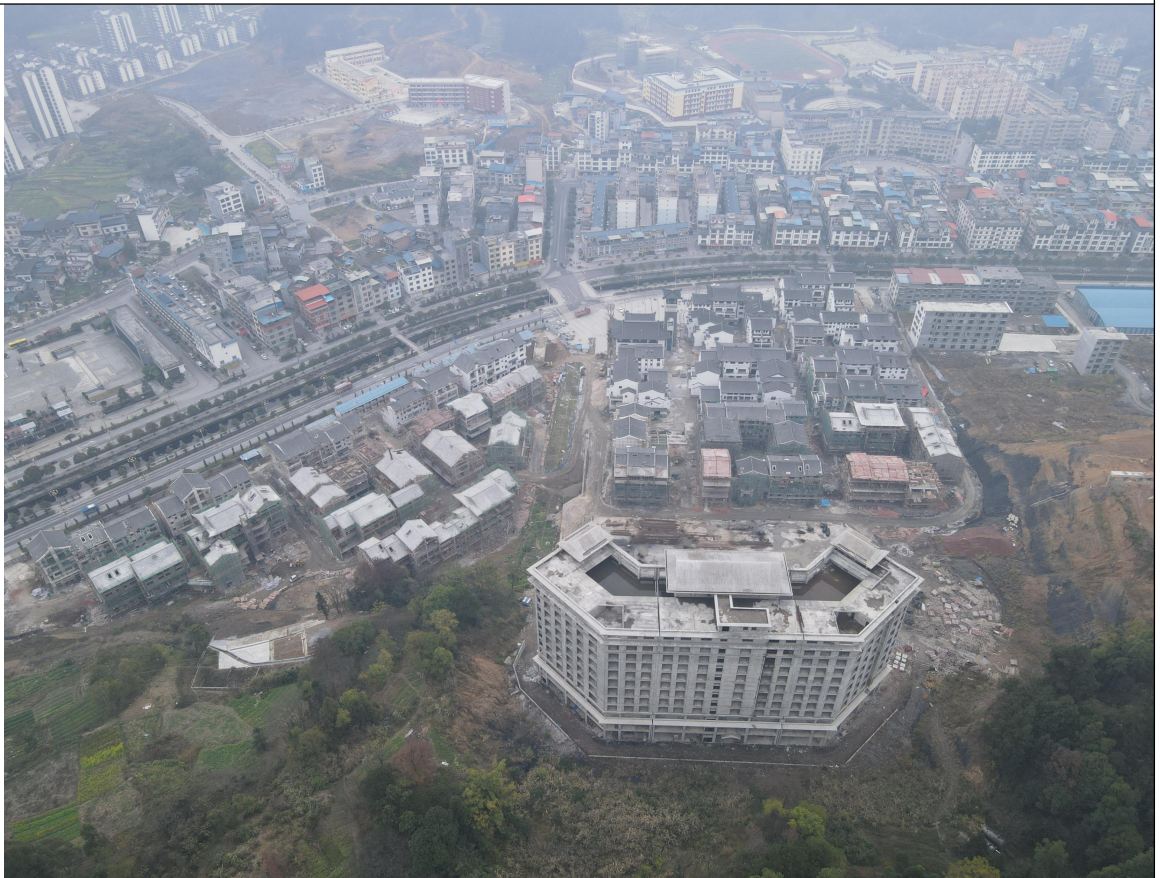
主体工程区施工现状（二）
