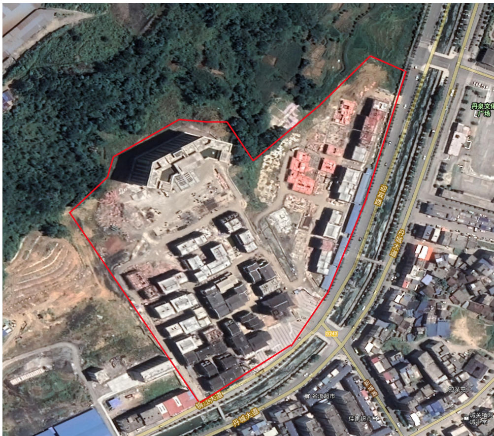
主体工程施工现状（一）
