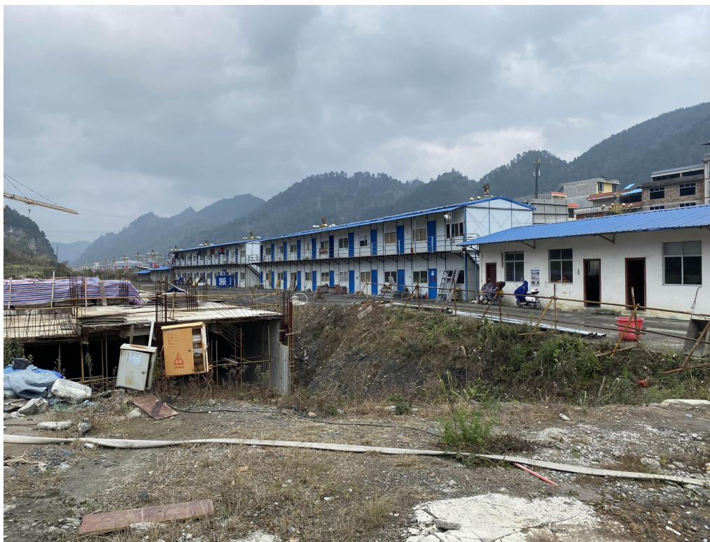
施工生产生活区现状
