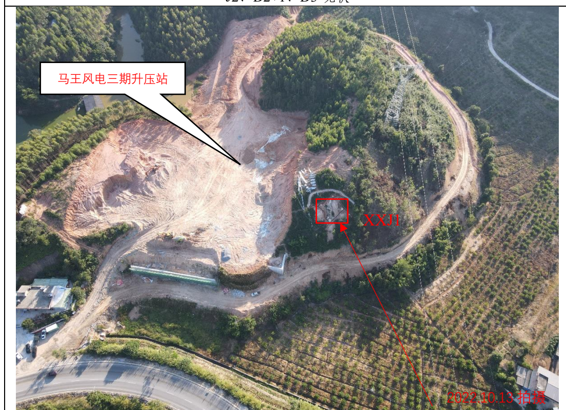
XXJ1、马王风电三期升压站施工现状
