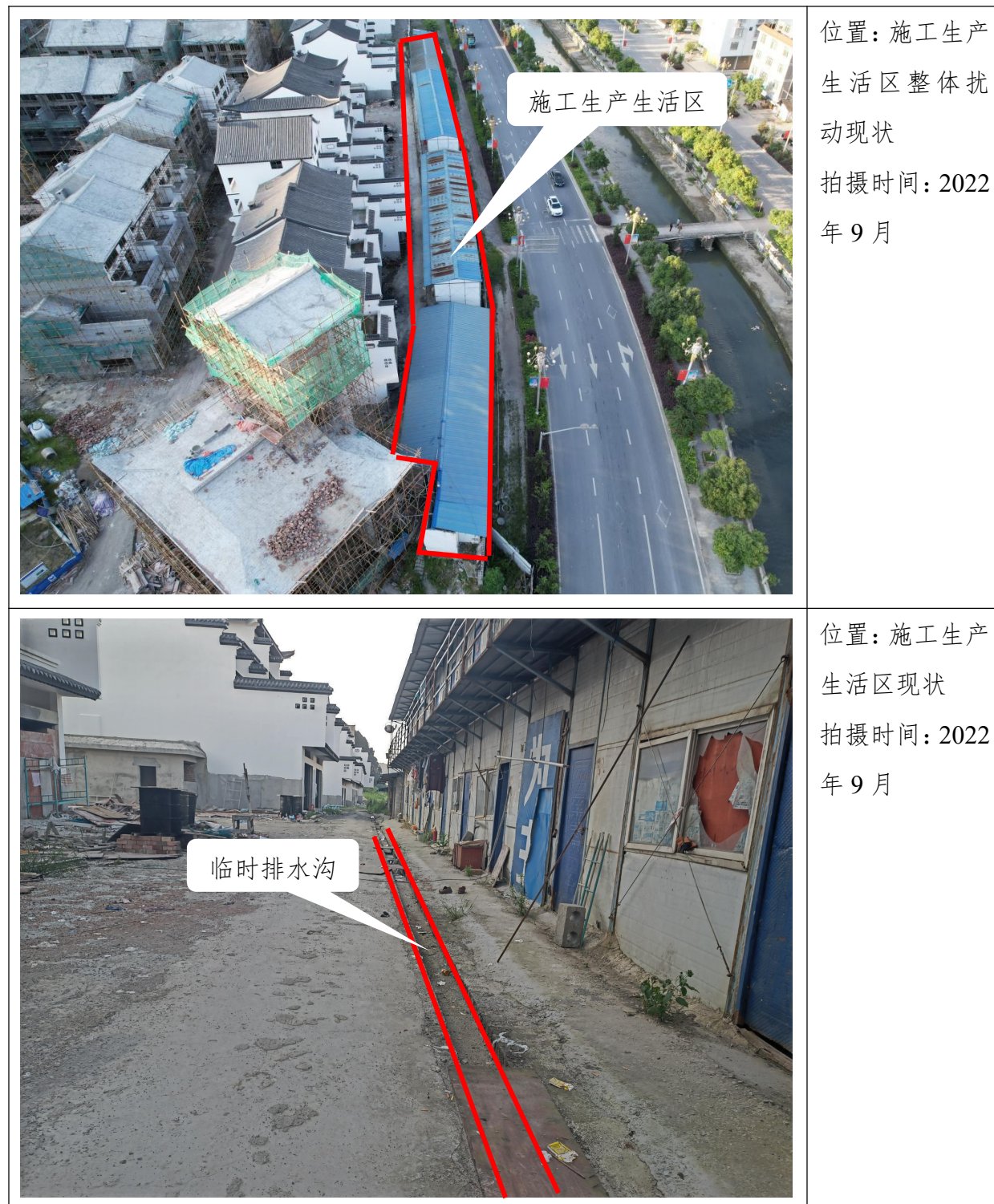
图 3.1-2：施工生产生活区场地照片：
