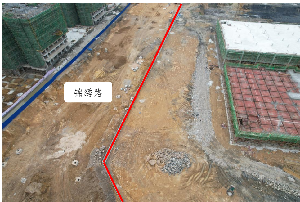
图 3.1-1：主体工程区场地照片
