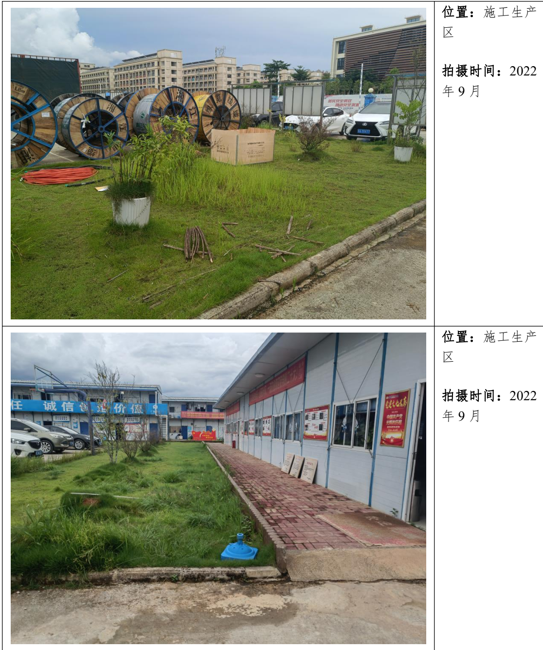
图 3.1-2 施工生产区现状照片
