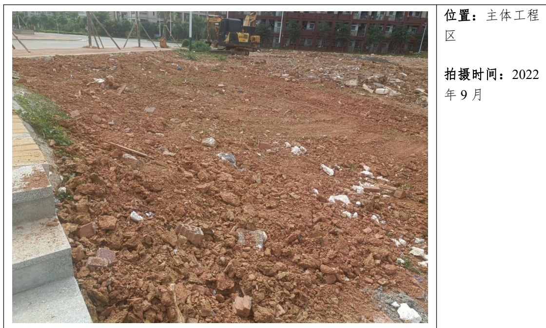
图 3.1-1 主体工程区现状照片
