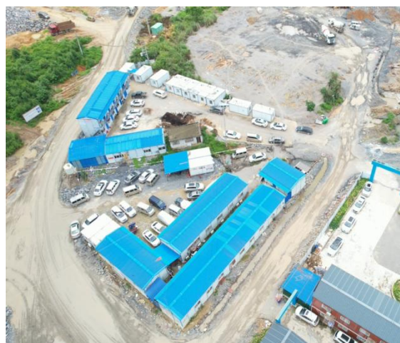
东面临时办公生活区现状
