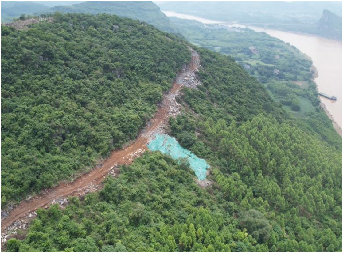
矿山道路区填方边坡采取密目网覆盖
