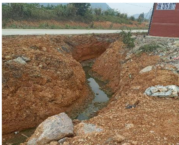
临时办公生活区西侧临时排水沟现状
