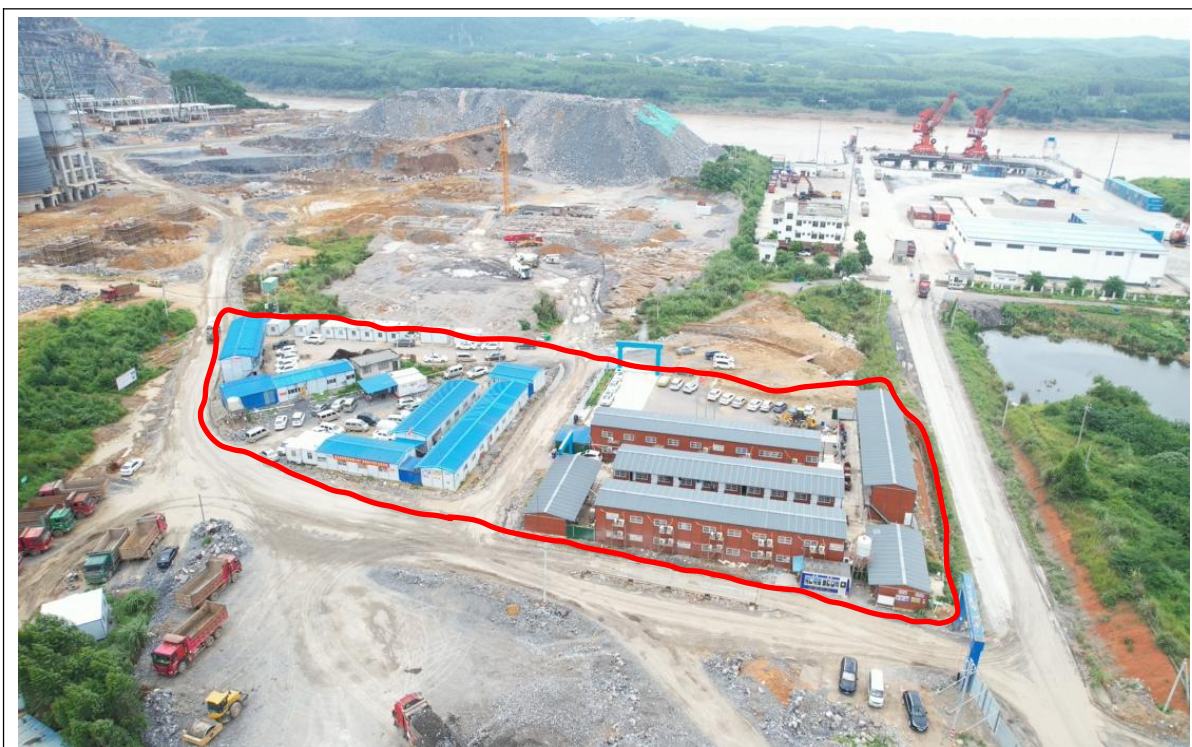
临时办公生活区整体现状
