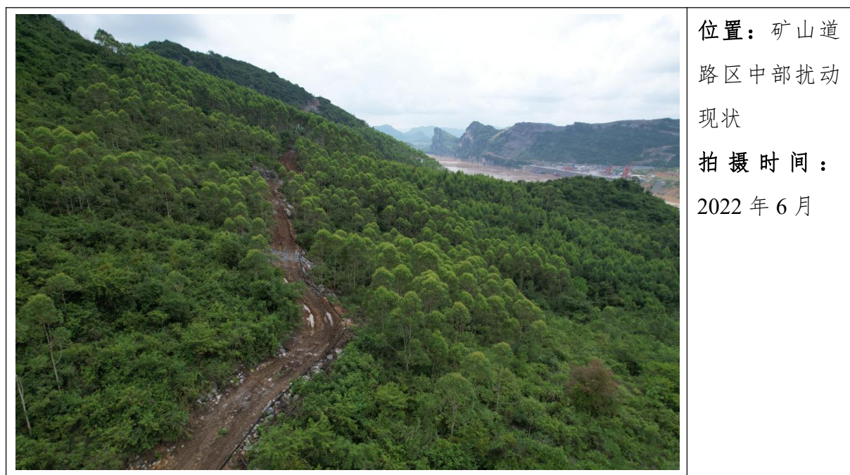
图 3.1-3 矿山道路区现状照片
