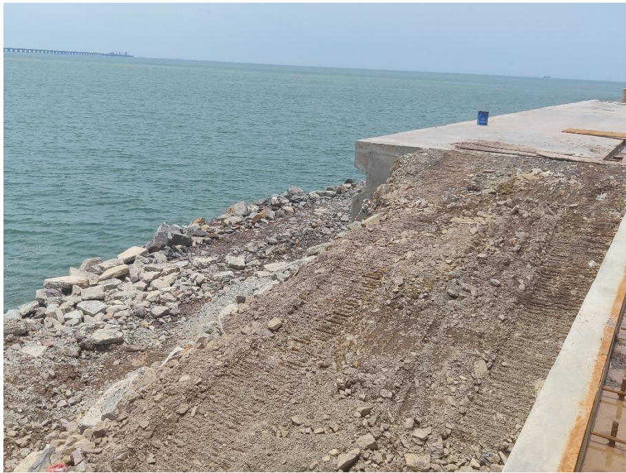
2#码头左侧廊道回填施工作业
