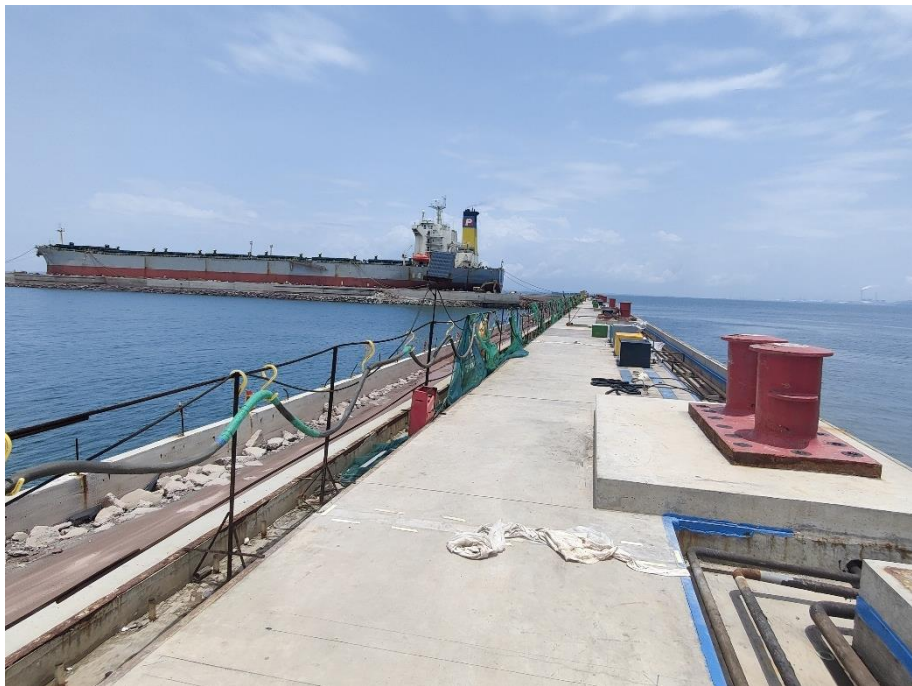
5#码头东侧廊道现状
