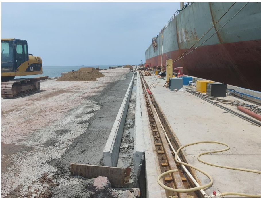
2#码头北侧廊道现状
