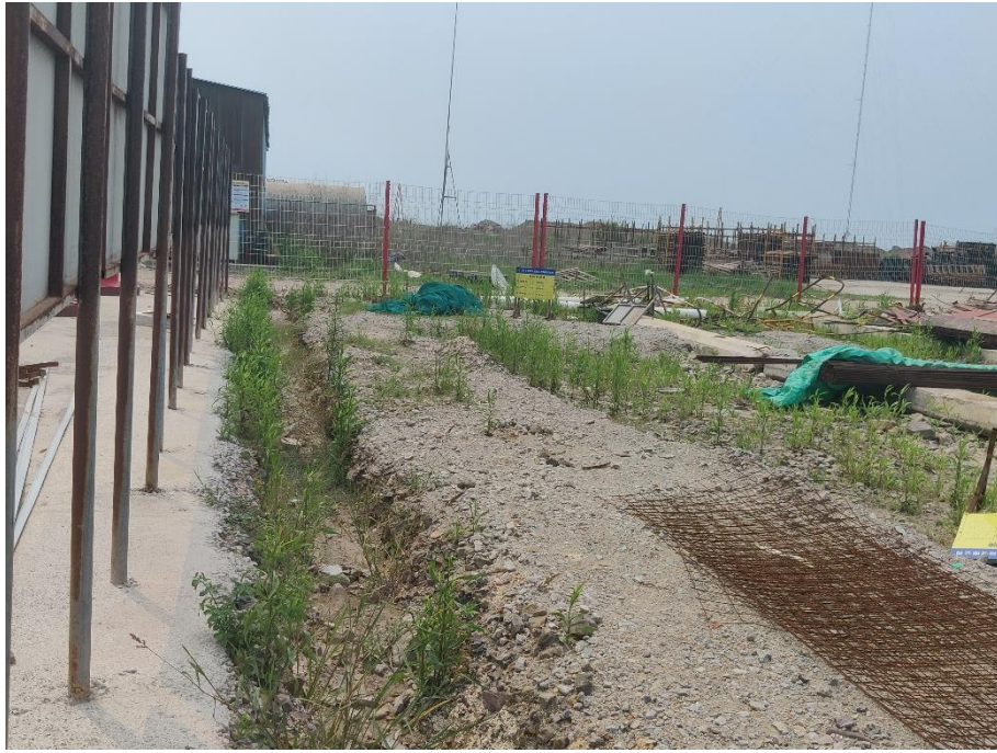
1#施工生产区的临时排水沟现状
