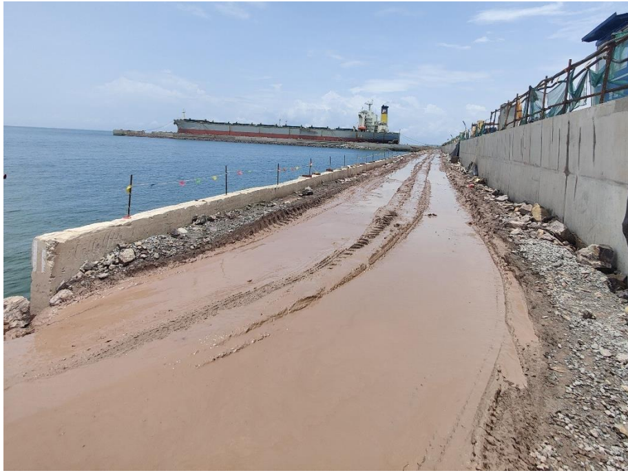
5#码头西侧廊道施工现状
