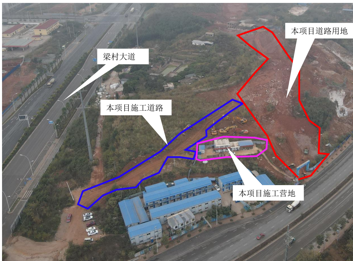
图 1.1-2 施工便道现状位置
