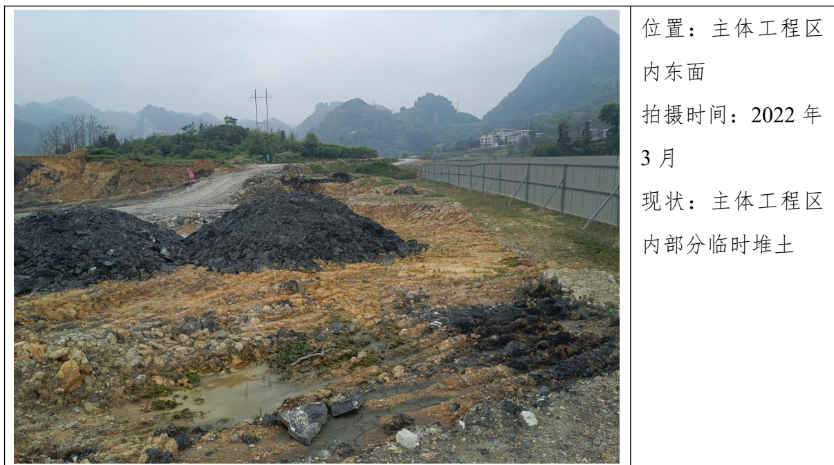
图 3.1-3 临时堆土区现状
