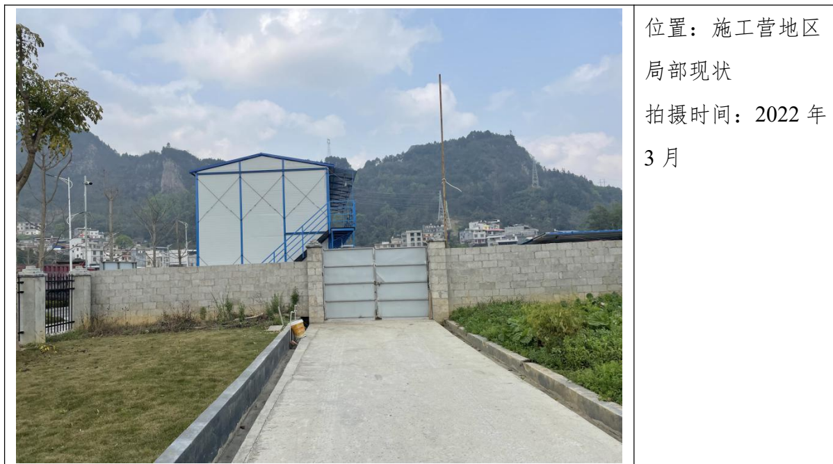
图 3.1-2 施工营地区现状
