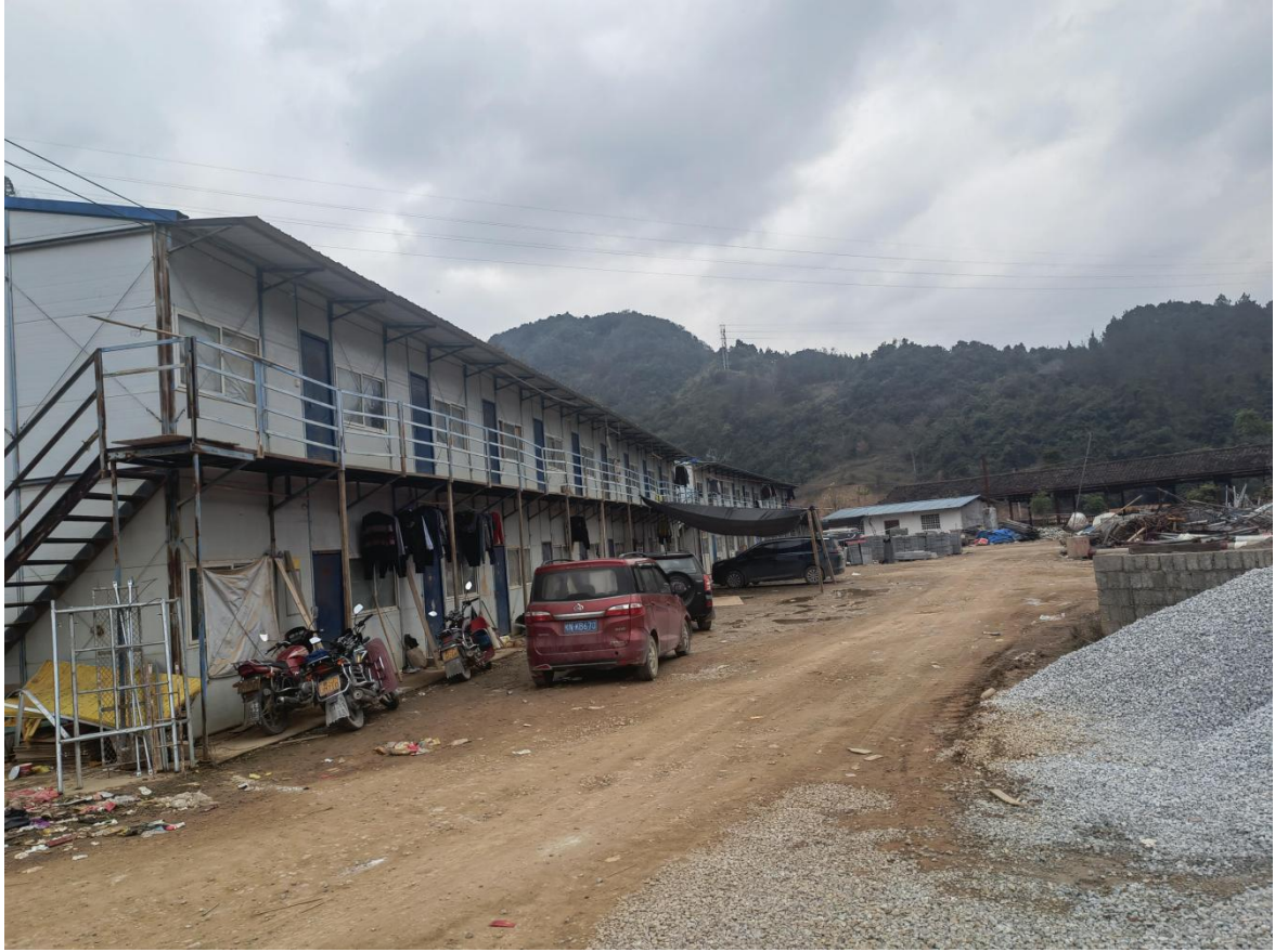
施工生产生活区局部现状
