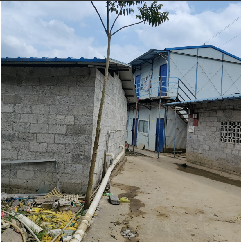
施工生产生活区局部现状
