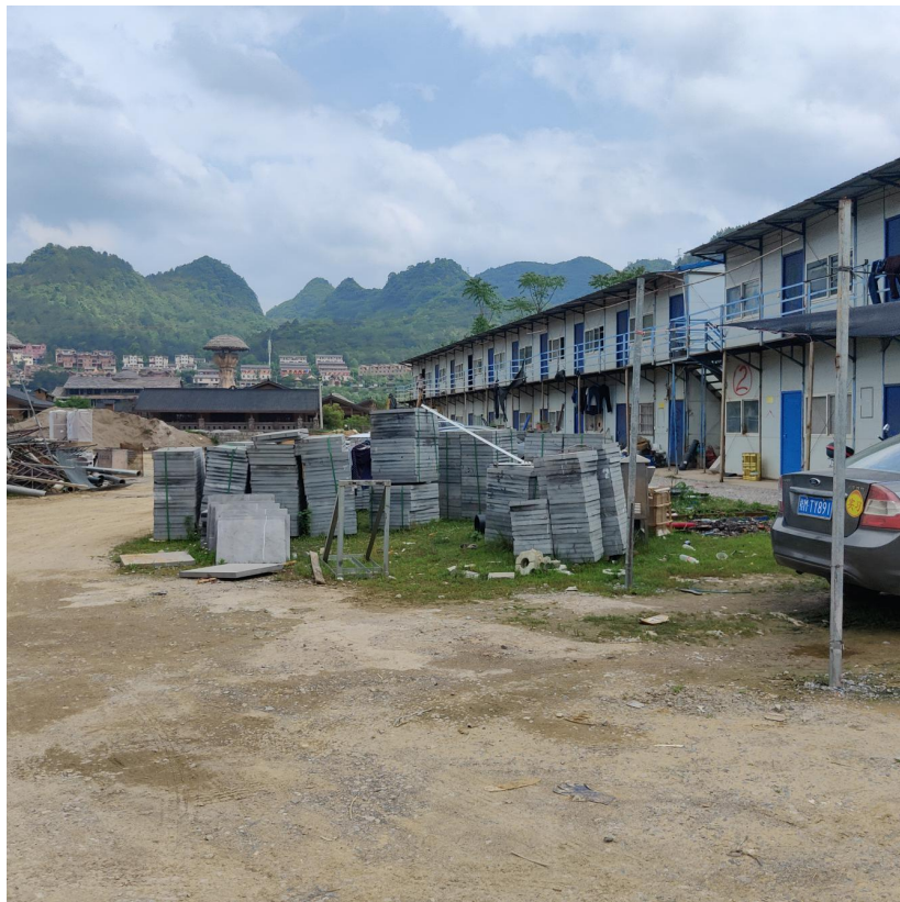
施工生产生活区局部现状
