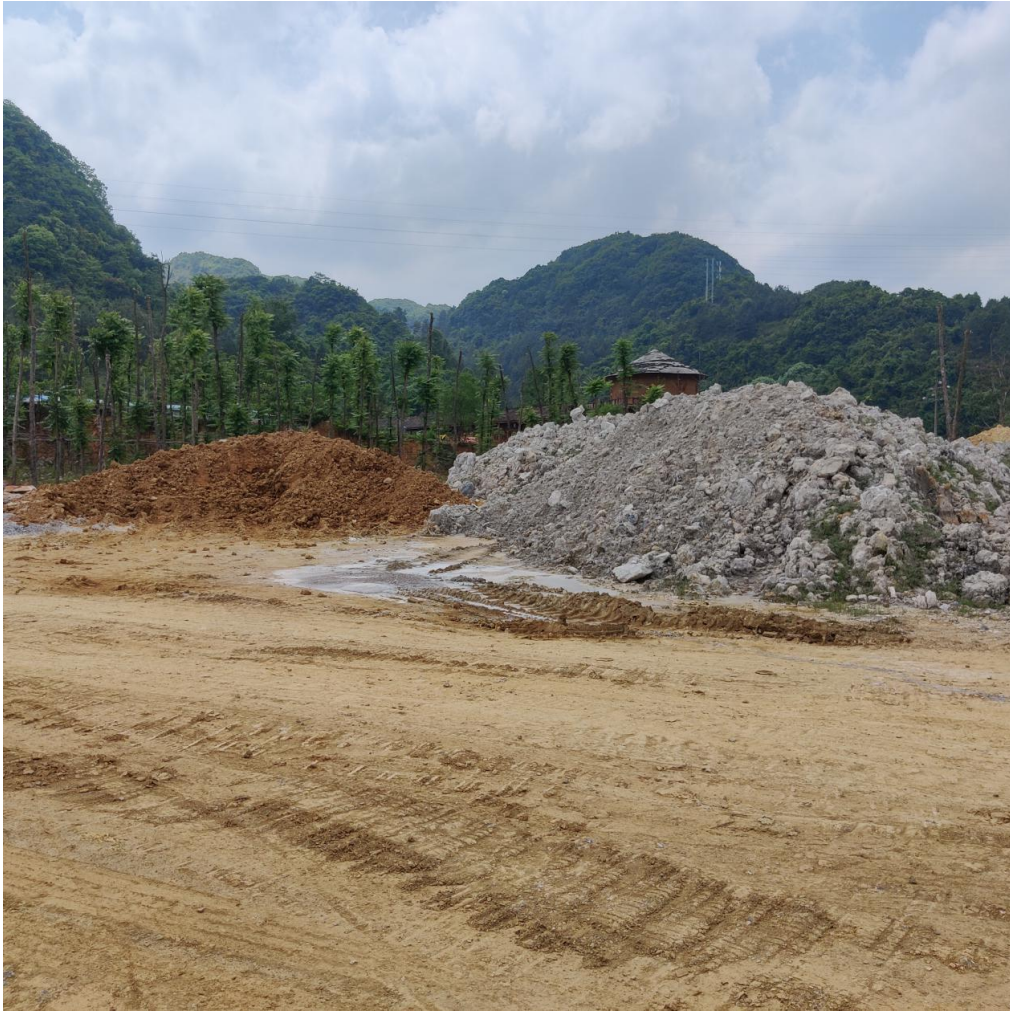
临时堆土场区局部现状
